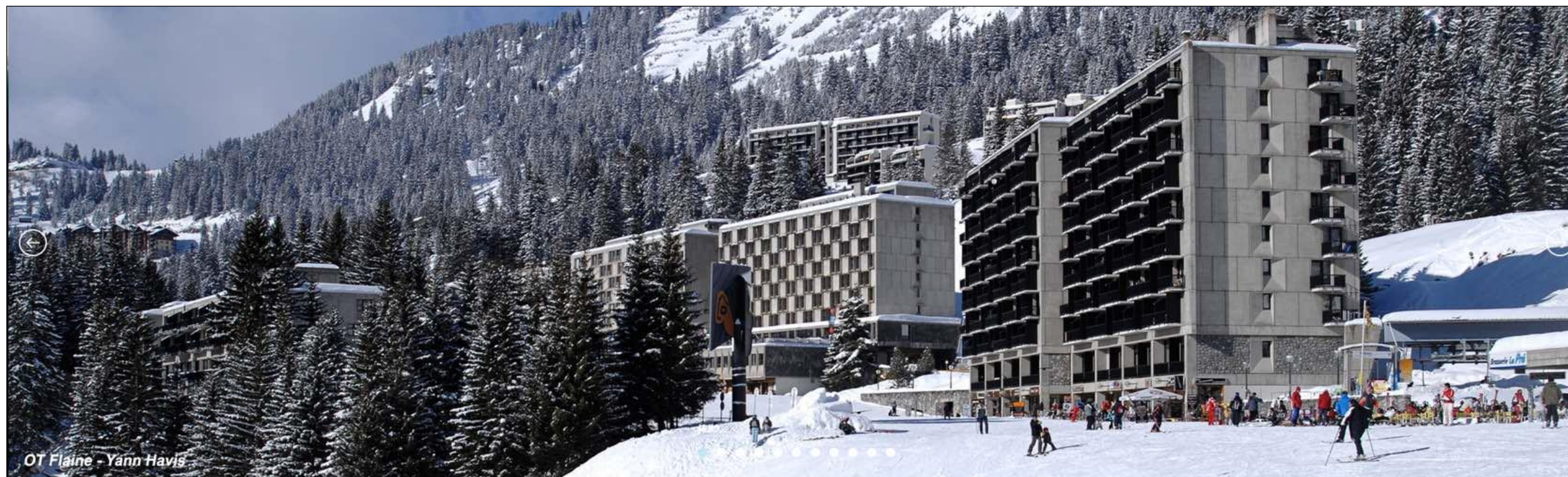
Document 3a : Une station intégrée (photographie de l'OT de Flaine)
