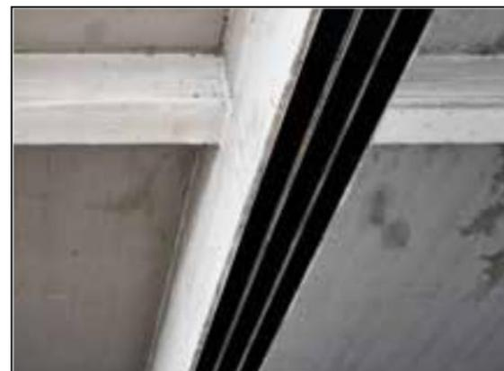
Exemple de lamelles collées en sous-face d'une poutre
